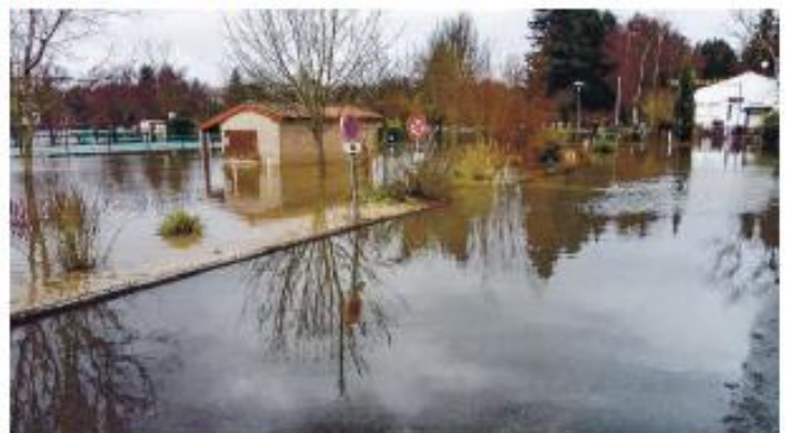
Les eaux de la Vienne en crue débordent comme ici à Availles-les-Bains.
