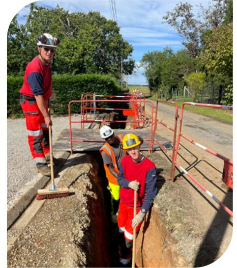
**L**es travaux de rénovation du réseau de distribution d'eau potable se poursuivent. 27 branchements et 930 mètres de canalisation seront remis à neuf, d'ici quelques semaines, sur les villages du Couret et de Peussicot. Une borne incendie sera également installée sur ce village.
